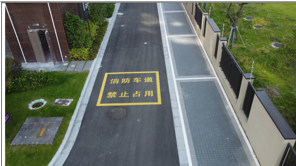
雨水管网及停车位透水砖
