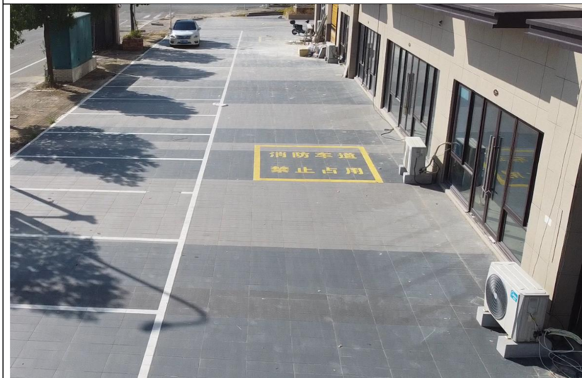
小区沿街商铺前地面停车位硬质铺装
