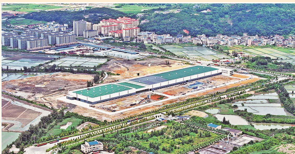
福安青拓矿卡及总成部件项目一期厂房目前建设完成。据了解,该项目建设了生产制造、装配、试验、仓储、办公所需的厂房及配套生产设施。 张文奎 摄
