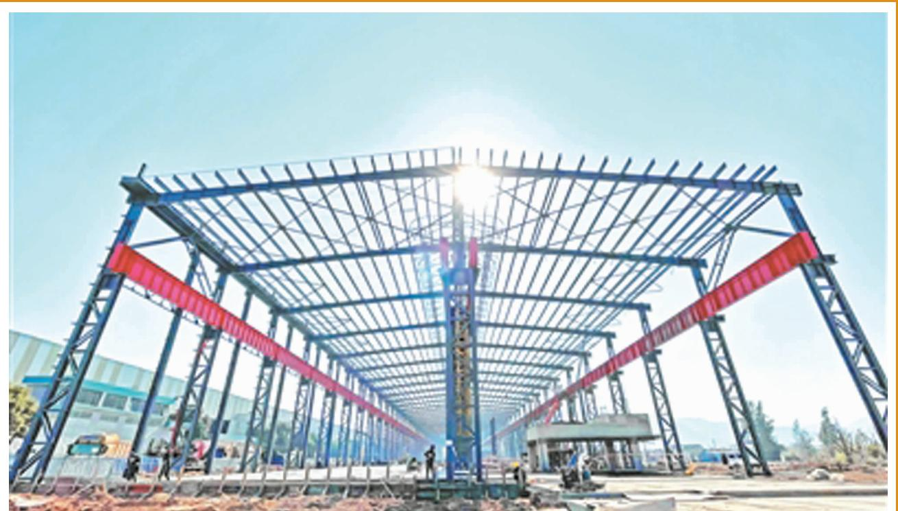
近日,记者来到湾坞宏旺年增130万吨不锈钢冷轧扩能项目现场,看到工人正在进行主厂房设备基础施工、厂房钢结构安装。目前,主厂房钢结构施工已完成60%,预计今年6月进入试生产阶段。该项目分两期建设,项
