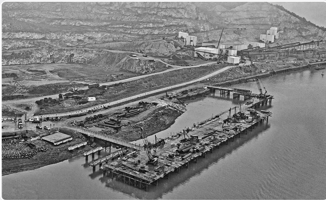
日前,下白石的福州港白马港区坪岗作业区4#、5#泊位工程现场一派热火朝天景象。项目护岸及陆域回填部分地基基础施工已完成,正在进行棱体及堤心分级回填施工和后方陆域回填料施工。
