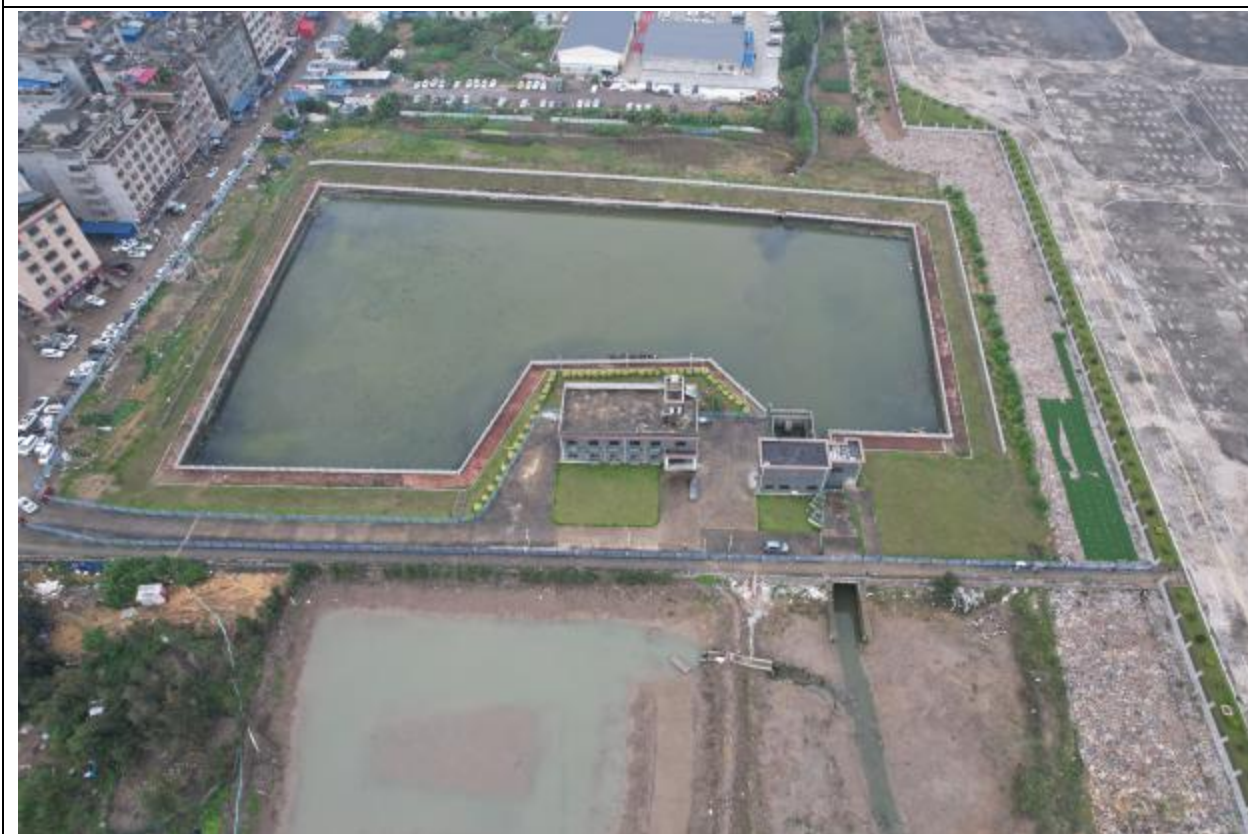
项目区全景照片（自然恢复期）
