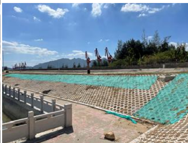
主体工程区生态护坡 (2022 年第三季度)
