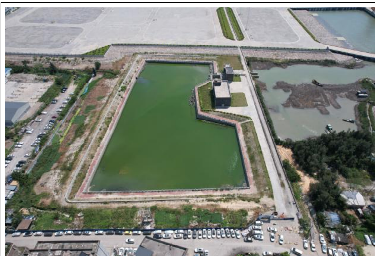
项目区全景照片（自然恢复期）
