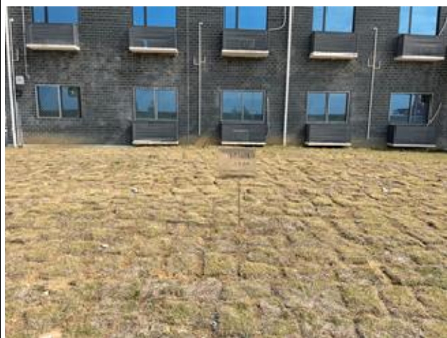
主体工程绿化工程 (2022 年第四季度)
