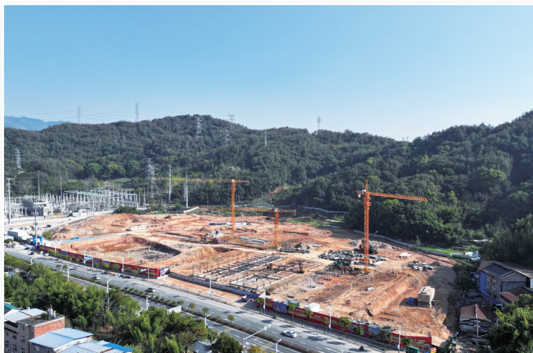
项目建设现场
