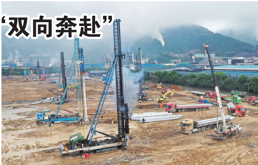
青拓特钢不锈钢中厚板项目现场
