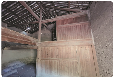
溪塔村大木构架
