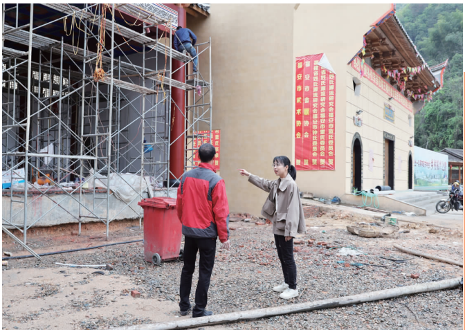
兰玲星与施工方沟通畲族歌舞台建设
