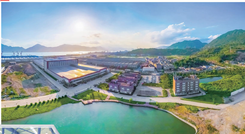
宁德新能源材料循环经济低碳产业园(福安青美)
