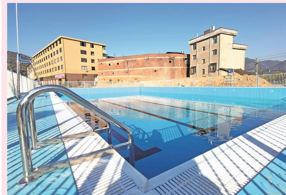
日前,我市2个拆装式游泳池(坂中畲族乡坑下村游泳池、罗江街道南安村游泳池)已建成并即将投入使用。该项目是根据省委省政府及福建省全民健身领导小组办公室相关指导精神文件建设的全民健身和民生项目。据了解,拆装式泳池建在普通水泥平地上,如同一个巨大的方形水箱,占地面积700平方米,由池体(池岸、上下水扶梯、安全护栏等)和全套水处理消毒系统组成,周边还配置有更衣间、淋浴间、卫生间等附属用房。拆装式游泳池可拆卸不用挖地动土,建设成本低。夏天当成泳池,其他时候,原有场地可变身为篮球、网球、门球等运动场地。夏季“野泳”易发生意外,拆装式泳池投入使用后,可减少安全隐患 张文奎 摄
