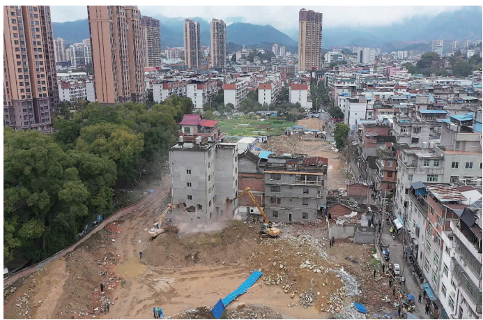
栖云桥建设用地范围内违法建筑物拆除现场
