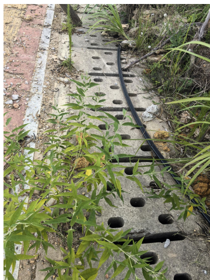
现状路基边沟
