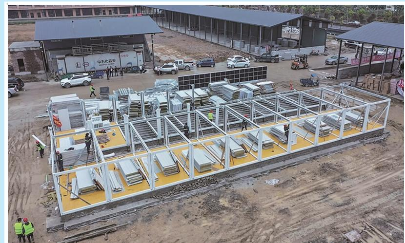
3月30日,位于湾坞镇新城小区南侧的健康驿站(方舱隔离点)项目现场,100余名施工人员正争分夺秒地开展场地平整、地基浇筑、箱房材料安装等工作,全速推进项目建设。据了解,福安市健康驿站(方舱隔离点)专用于接收密切接触者,总占地约28亩,建筑面积9930平方米,设置隔离方舱401间。
