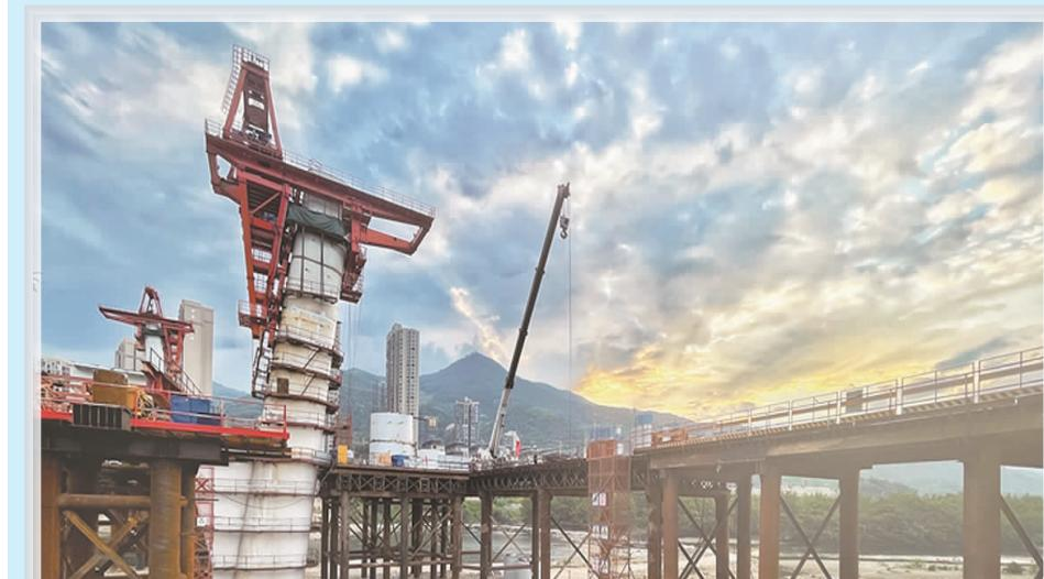
8月12日，宁德市“双百”攻坚项目福安栖云桥工程正抓紧施工，目前已进入中塔柱施工阶段。据了解，栖云桥项目自2020年3月动工，工期为两年，路线全长约760米，其中桥梁长度约340米，工程总投资1.58亿元，采用反对称钢塔钢箱梁斜拉桥，项目建成后将提高福安城区道路网的综合通行能力。
