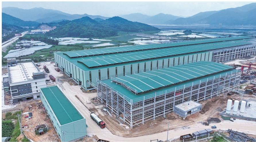
初秋,省重点项目福建青拓现代装备制造及重工配套项目一期建设现场,大型吊车挥动长臂有序作业,钢结构厂房雏形初现。项目自去年9月动工以来,已完成综合办公楼主体建设,目前一期厂房基础建设进度已超90%,钢结构安装完成80%,预计10月底进行试生产。
