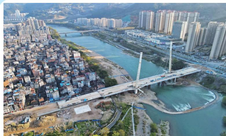
日前,记者来到福安栖云大桥施工现场见到,继续主桥和引桥主体施工,计划8月主体竣工。据了解,1—2月完成投资1710万元,占年度计划17.10%,目前桥梁主体基本完成,正准备进行斜拉索安装;引桥主体、路基挡土墙完成施工,开始路基施工。
