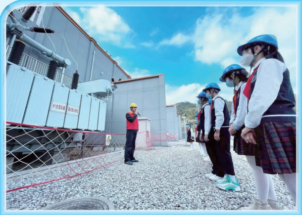
小记者们在参观变电站室外的主变压器
