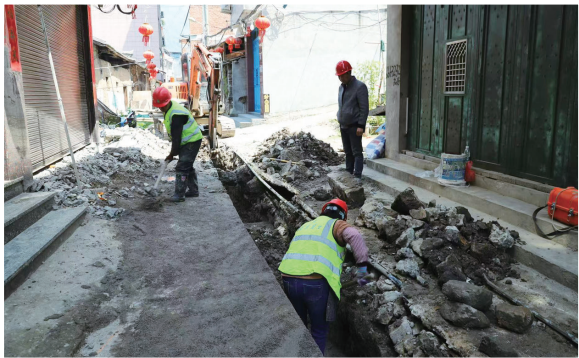
施工人员开挖巷道管沟
