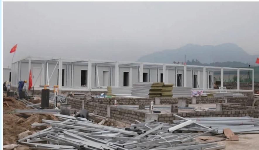
4月18日,福安市国际健康驿站建设现场,机器轰鸣,工人不停忙碌着,白色的方舱已经逐渐搭建起来,水电、道路等配套设施也同步建设。据了解,福安市国际健康驿站位于湾坞11号码头泊位后方,占地15亩,建设方舱96间(其中隔离间60间)。项目按照三区两通道要求设计,由福安市城投集团组织建设,国企省能化集团下属联美建设集团公司施工。项目预计本月底完工。
