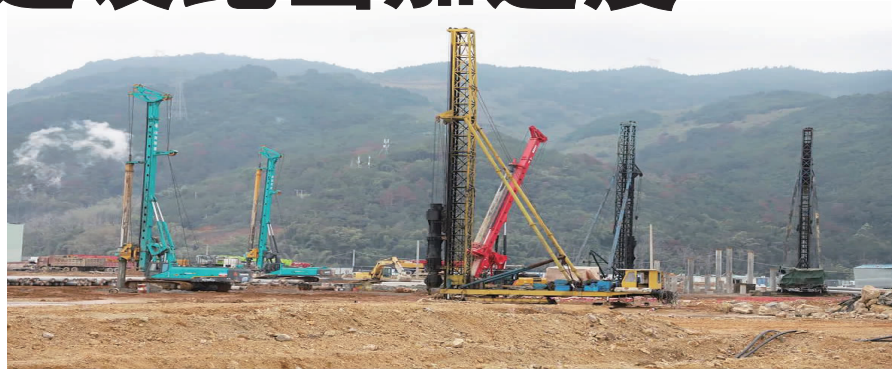
青拓高性能不锈钢新材料及配套项目(一期工程)的施工现场
